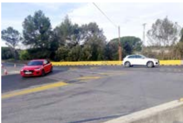
La rotonda en construcción cruce carretera
